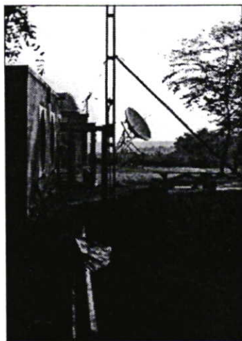
De AGOM-zendmast in aanbouw op het terrein voor de sterrenwacht.
